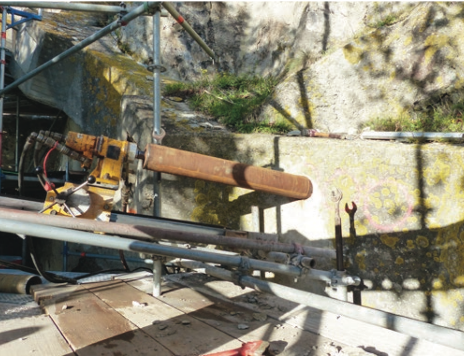
Bohrlafette zur Herstellung einer Kernbohrung zum Einbau eines neuen Spanngliedes Bild: Prof. Dr. Strauß
