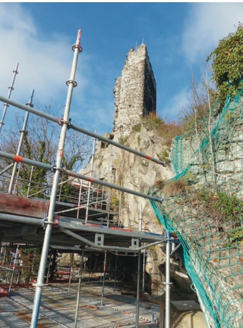
Einrüstung der Felswand mit Netzverspannung des alten Mauerwerks Bild: Prof. Dr. Strauß
